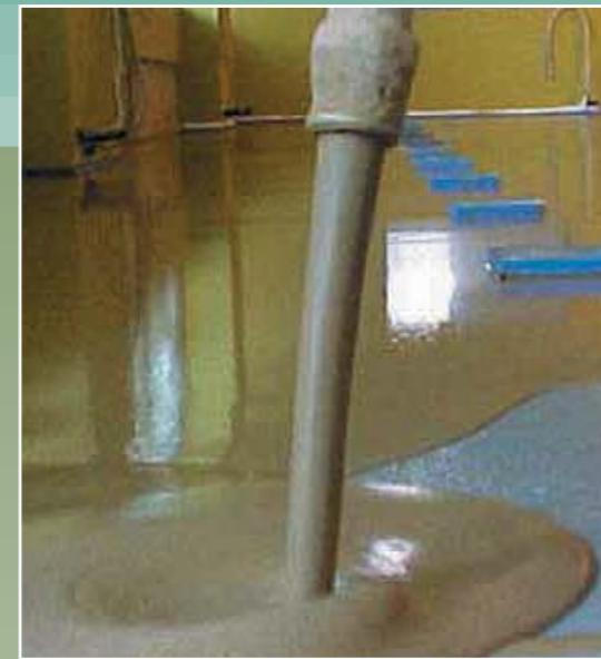
затвердеет (при прикосновении остается отпечаток). Необходимо заранее починить трещины в основании, применив Eporip.
