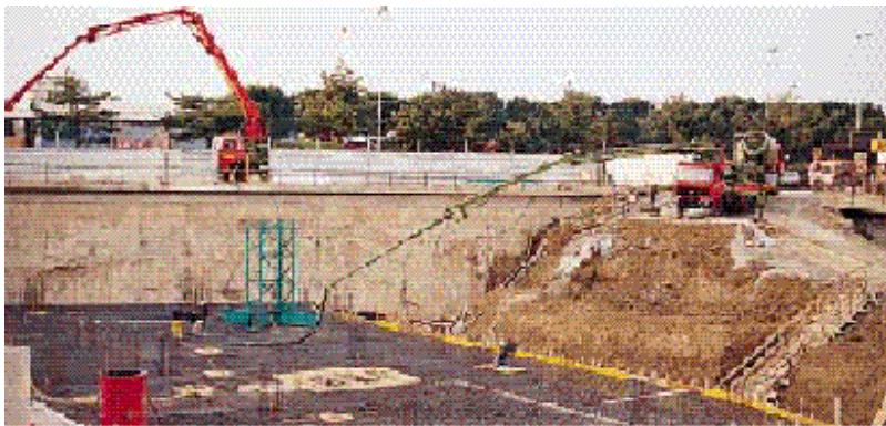
Отливка водонепроницаемой станины фундамента бетоном, подготовленным с использованием MAPEFLUID PZ500
