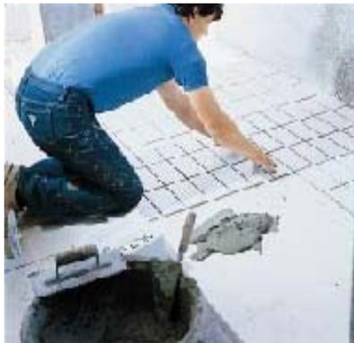
*Гидроизоляция патио с помощью **AQUAFLEX (СПЕЦИАЛЬНЫЙ ДЛЯ АСБЕСТА)** и последующей облицовкой плиткой*
