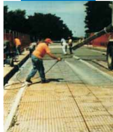
Applying the epoxy primer
