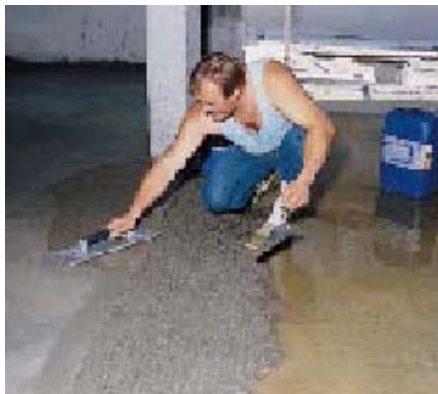
Разравнивание рейкой раствора с IDROSILEX (жидкий)
