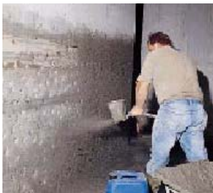
Нанесение распылением первого слоя раствора с IDROSILEX (жидкий)
