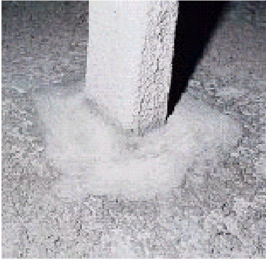
Гидроизоляция колонны с помощью IDROSILEX
