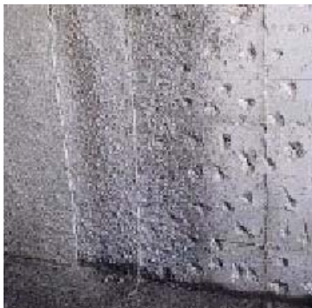
Применение раствора, смешанного с IDROSILEX по бетону
