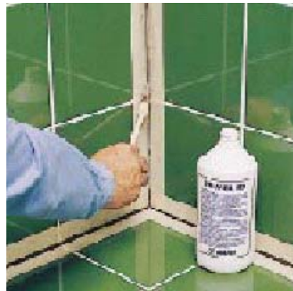
Нанесение PRIMER FD
