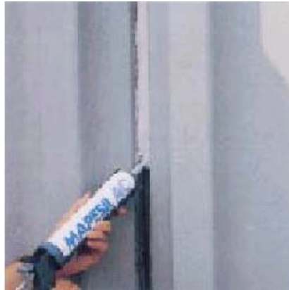
Заполнение швов между блоками сборного железобетона
