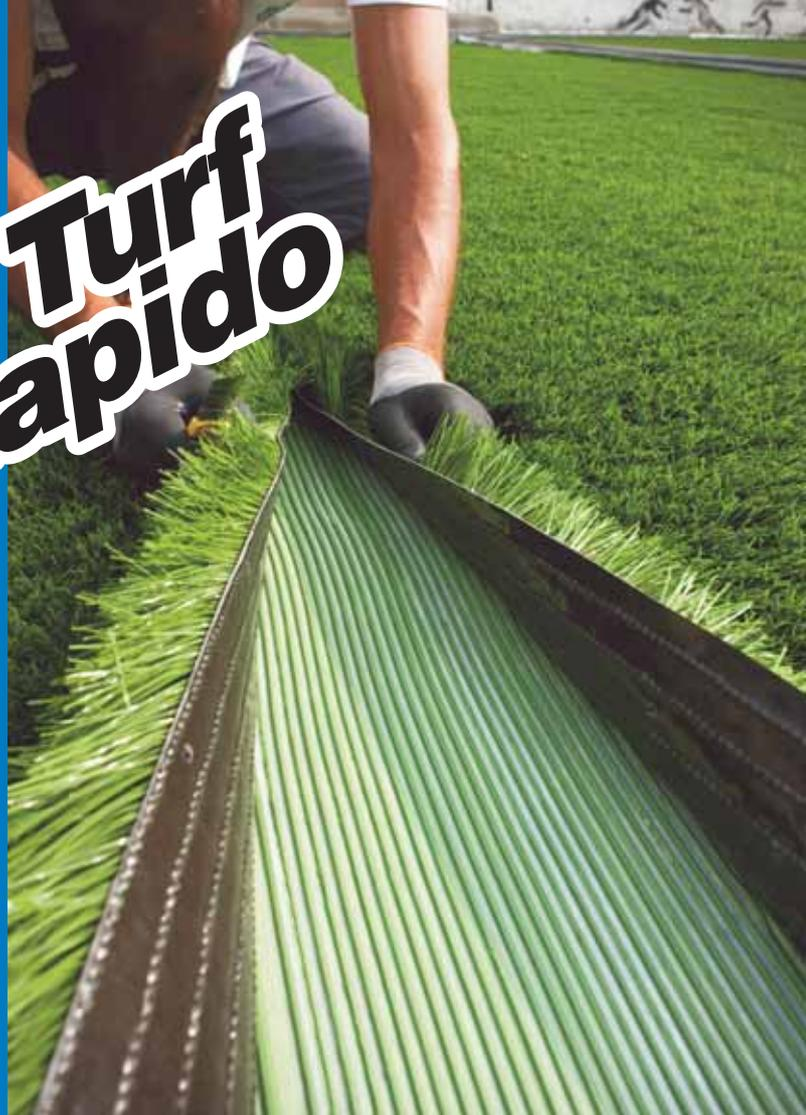
**Adesivo poliuretano a due componenti, esente da acqua e solventi, per l'incollaggio delle bande di giunzione tra teli di erba sintetica**
